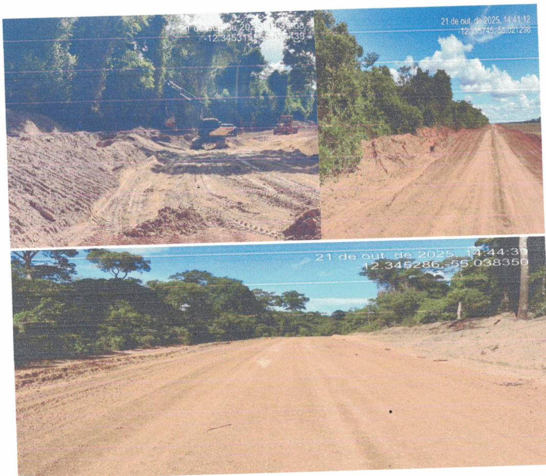
21/10/2025_Fiscalização de obra de levantamento de estrada e cascalhamento, na estrada nova IPE.
