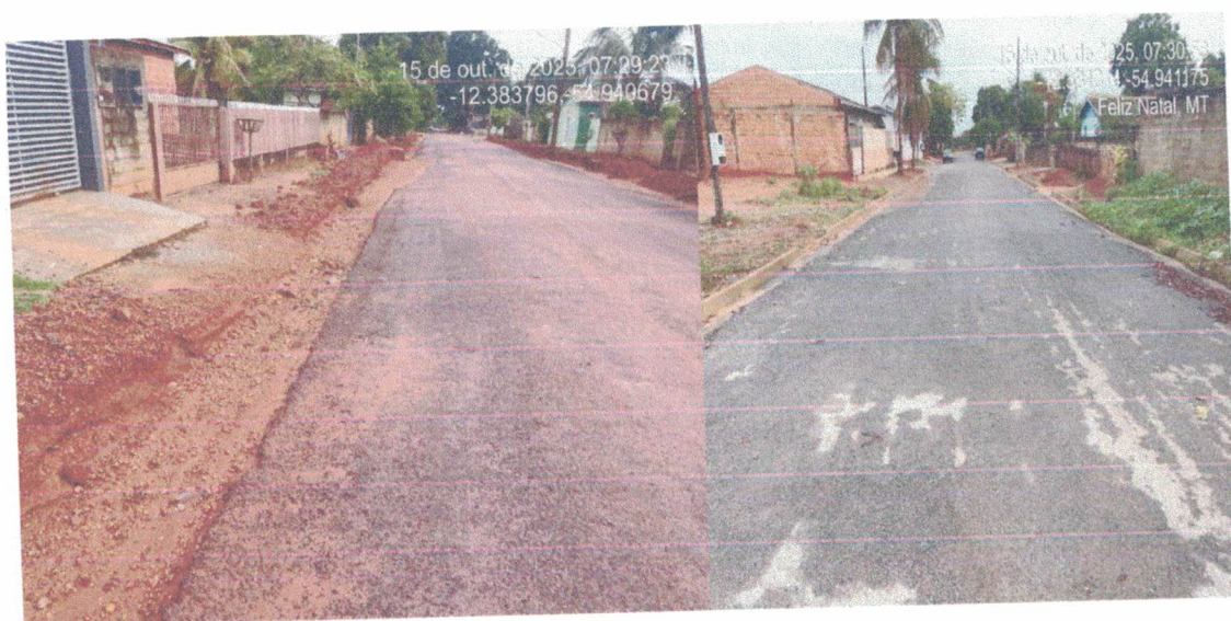
15/10/2025_Fiscalização de obra em fase final de pavimentação rua Joinville e rua Florianópolis.
