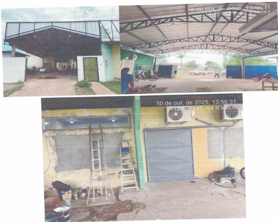
10/10/2025_Fiscalização da reforma do pronta atendimento e ampliação de cobertura.
