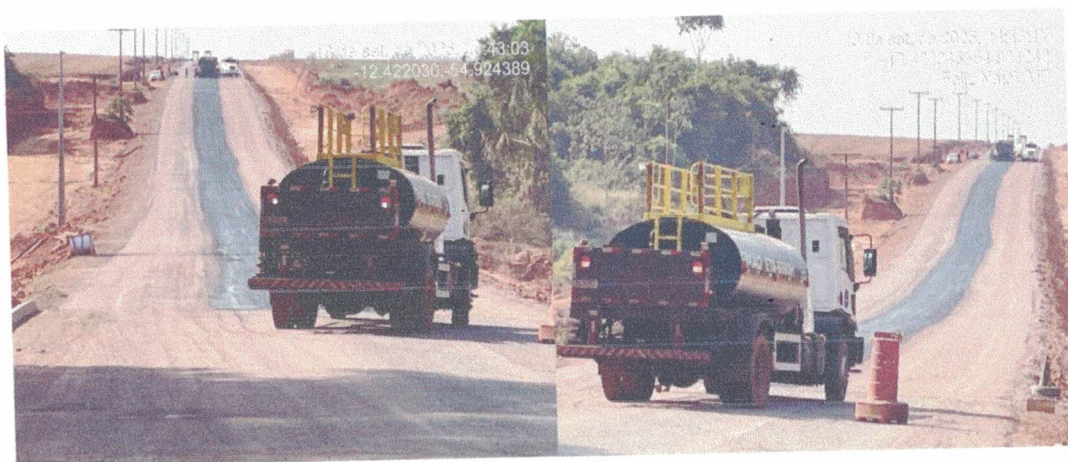
13/09/2025_Fiscalização de obra de pavimentação na Rodovia 130, sentido Cruzeirinho, trecho da Baixada Fazenda Debastiani, em fase de finalização.
